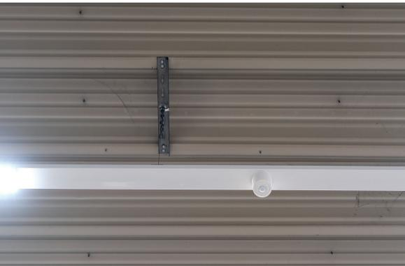
Smarte Unterstützung: Integrierte Sensoren optimieren den Energieverbrauch der LEDs zusätzlich.
